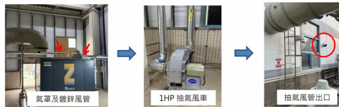
( 增設一台風車 配置鍍鋅風管及抽氣罩 將CDA機殼內熱氣抽至機房外 )
