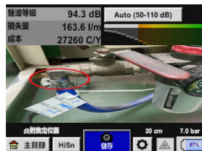
利用 LD500 找出洩漏點及洩漏量
