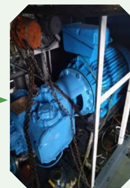
▲ 汰舊換新後之壓縮主機
